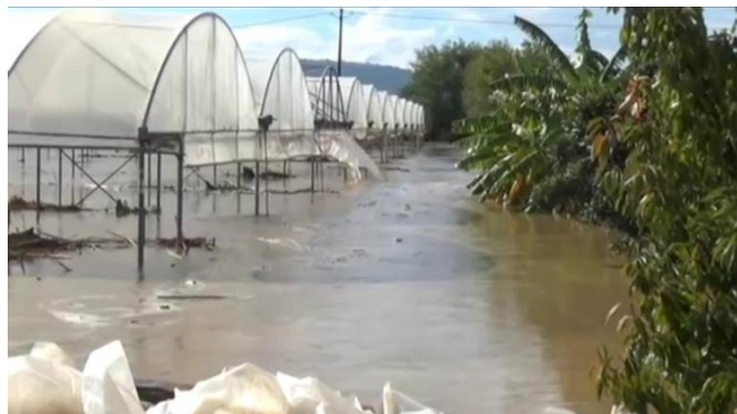
Serre allagate in provincia di Ragusa, esempio di danno al 100% su coltura e in parte anche sulla struttura agricola
