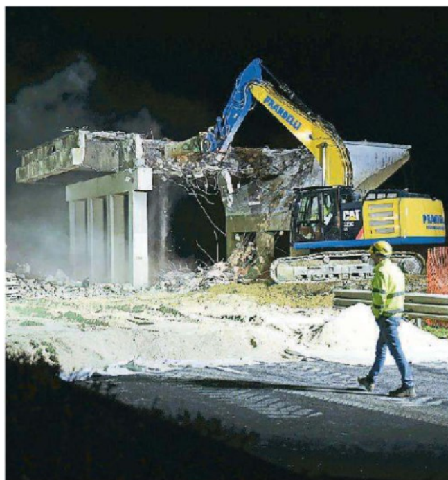
Il recente abbattimento di un cavalcavia per i lavori sull'A4
